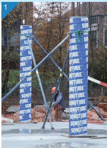
1 A csöveket függőlegesen állítsuk fel. A termék rögzítéséhez használjuk a SONAPLON rögzítő pántot.
