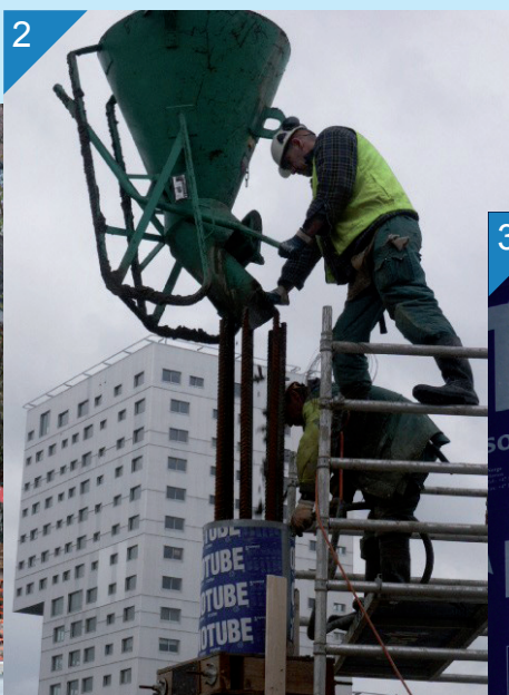
2 A speciális gyártástechnológiának köszönhetően a termékek mixer betonnal is tömöríthetők, 4,5 m/h gyorsasággal
